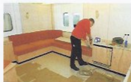
AUSBAU: Im Inneren des Deckshauses geht es zu wie beim Hausbau an Land.
